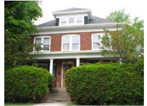
437 N. Superior St. American Foursquare
