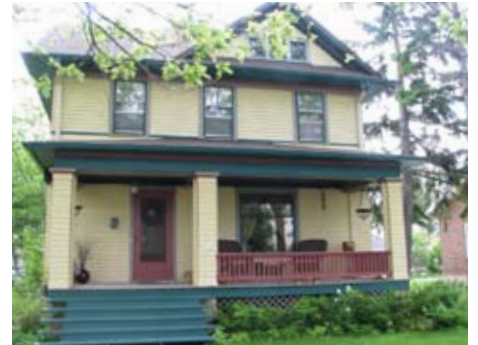
220 N. Michigan St. American Foursquare
