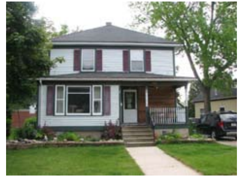
430 N. Michigan St. American Foursquare
