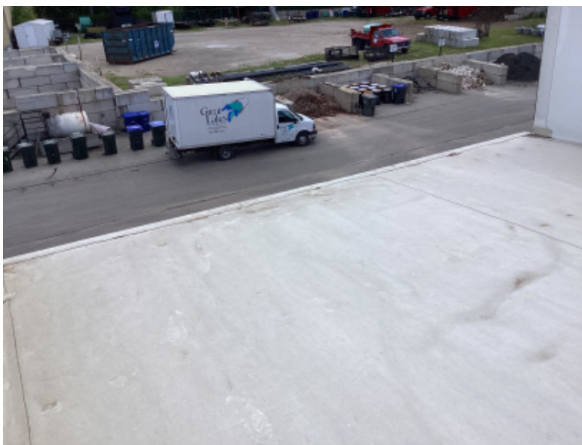
Leaking edge strip
